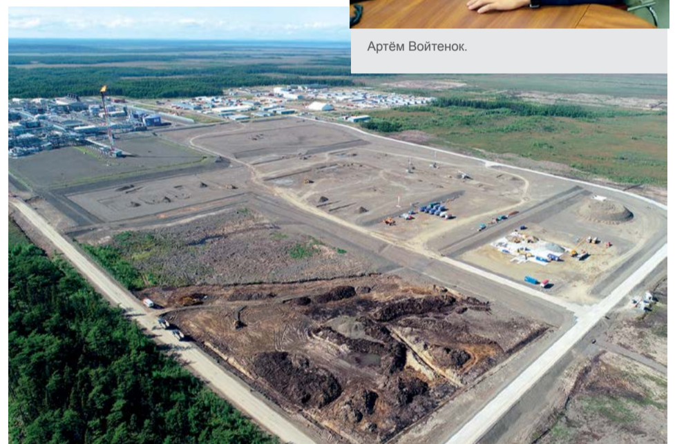
Площадка ДКС ОБТК.
